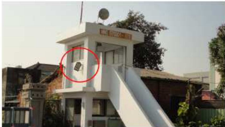
圖5-3 模擬平交道障礙物場地與設備
