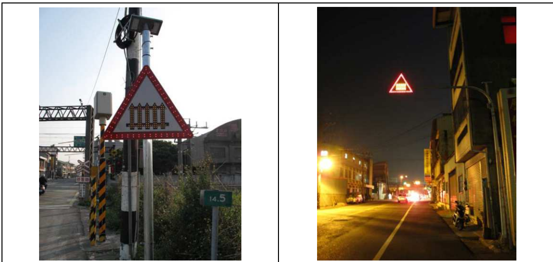
圖2-9 學田路平交道試辦 LED 閃燈警 25 標誌現場照片
