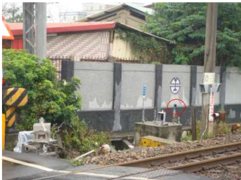
圖5-20 偵測南下列車到達感測器
