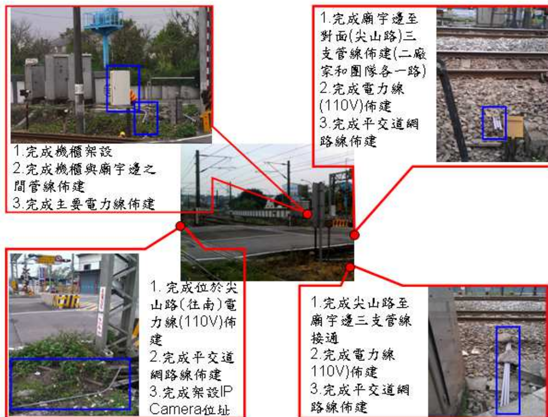
圖5-9 各項基礎設備佈建
