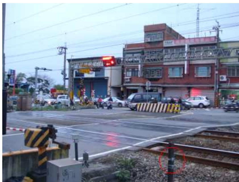
圖5-21 偵測北上列車到達感測器
